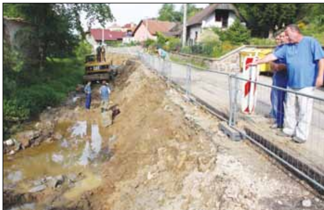
Práce při bourání a následné výstavbě nové opěrné zdi komplikuje tvrdé podloží. V korytě potoka pracovníci narazili na skálu. Foto: Martina Strnadová
