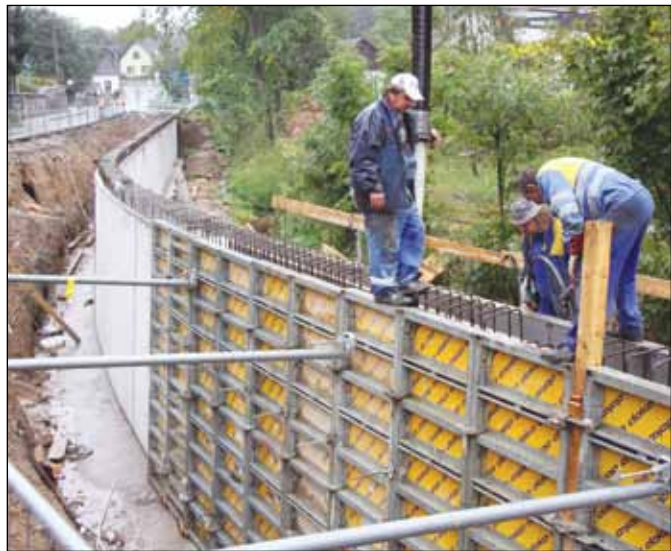
Práce na opěrné zdi zachycují stav v pátek 31. srpna 2012 dopoledne. Foto: Martina Strnadová
