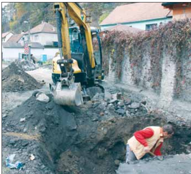
Výkopové práce při stavbě kanalizace na Příkopech zpomalují tvrdý syenit či třeba vodovod, který je nutno přeložit. Foto: Martina Strnadová
