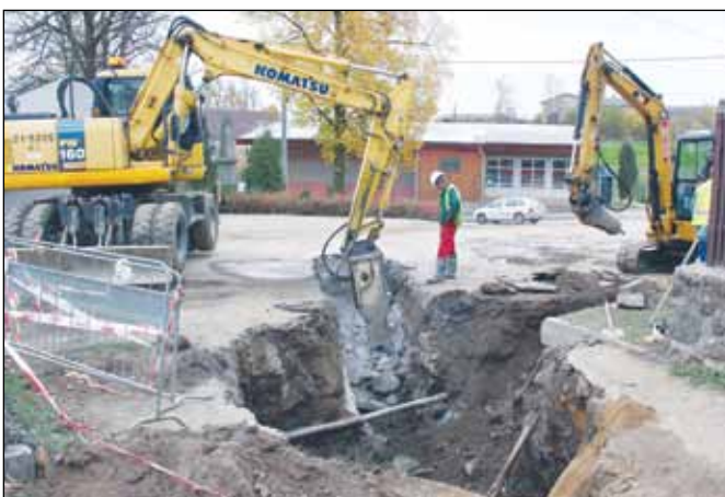
Nový povrch v Oslavici by měl být hotov letos pouze v části krajské silnice od vjezdu do vsi po křižovatku u prodejny. Foto: Martina Strnadová
