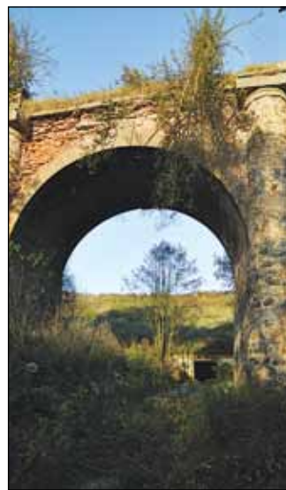
Vysoký most. Foto: Martina Strnadová
