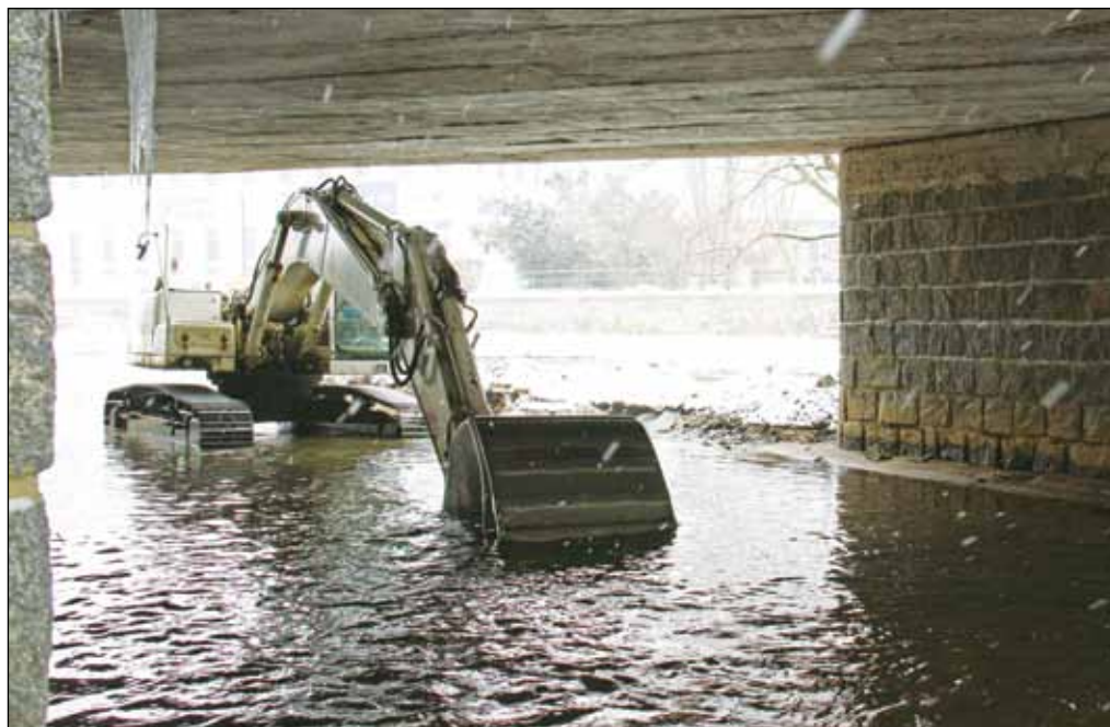
Prohrábka koryta pod mostem u pošty je taktéž součástí protipovodňových opatření. Foto: Martina Strnadová
