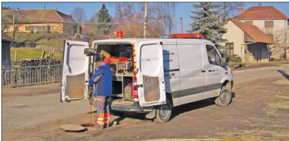
Snímek zachycuje kamerové zkoušky kanalizace v Mostištích. Foto: archiv správce stavby
