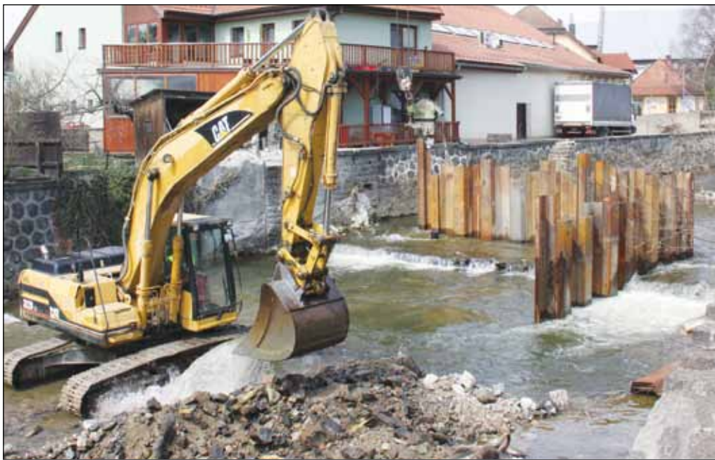
Snímek zachycuje práce na stavbě nového jezu na Moráni. Další fotografie protipovodňových opatření najdete na straně dvě. Foto: Martina Strnadová
