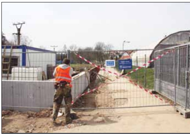
Stejně tak se pracuje na protipovodňové ochraně města na Paloukách. Foto: Martina Strnadová
