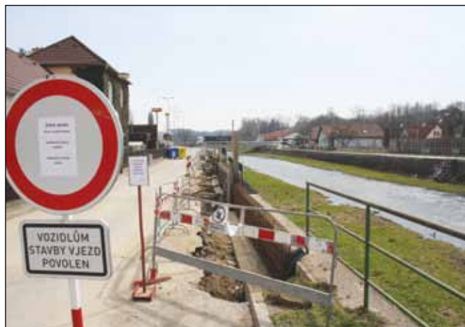
Práce na protipovodňové ochraně města na nábreží. Foto: Martina Strnadová
