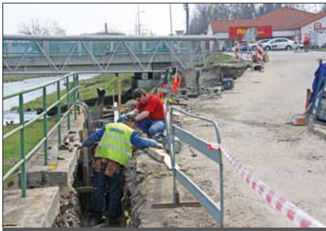
Na druhém břehu řeky naproti Penny se betonují základy zídek. Foto: Martina Strnadová
