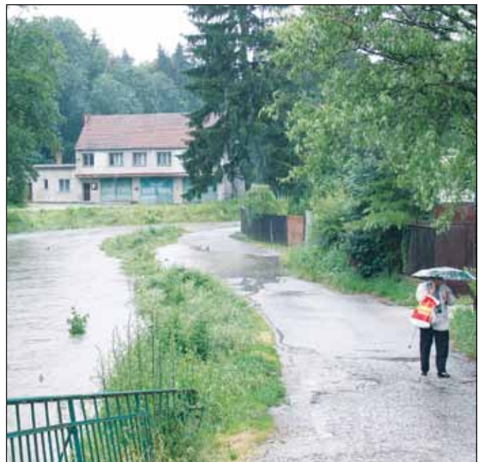
Úsek Balinky, kde v projektu protipovodňová stěna chybí a počítá se s rozlíváním vody, jako se to stalo naposledy 24. 6. 2013. Foto: Martina Strnadová
