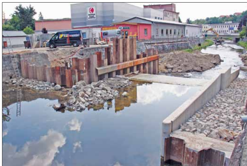
První polovina základu pro budoucí vakový jez na Moráni je hotova. Práce se nyní přesunuly do druhé. Jez bude mít rybí skluz. Foto: Martina Strnadová
