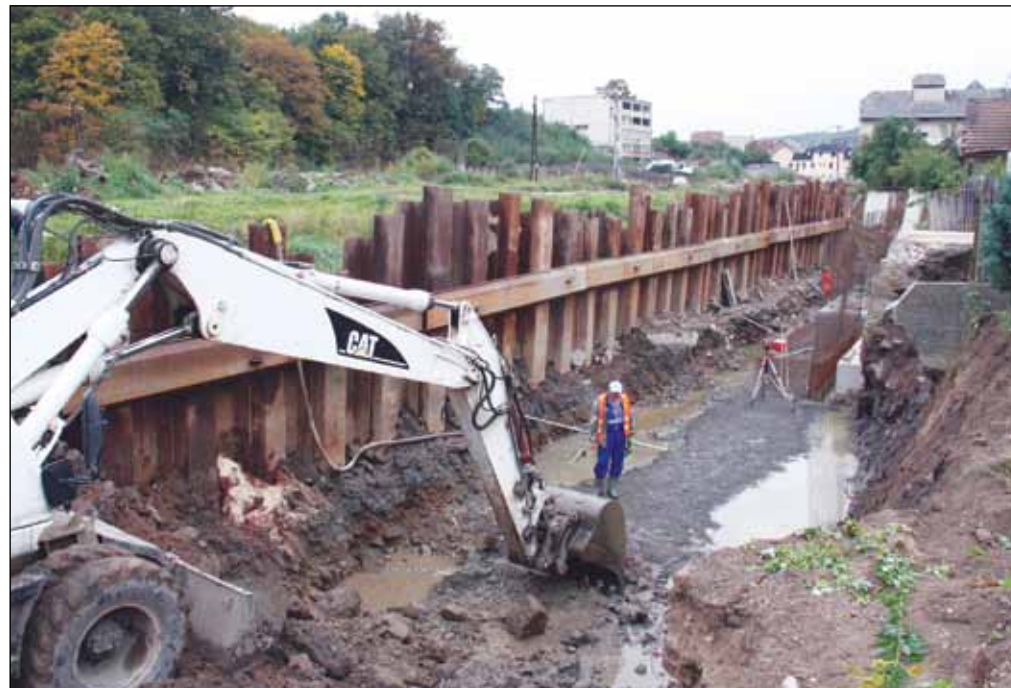
Při stavbě opěrné zdi před soutokem Balinky s Oslavou pracovníci narazili na archeologické nálezy. Foto: Martina Strnadová
