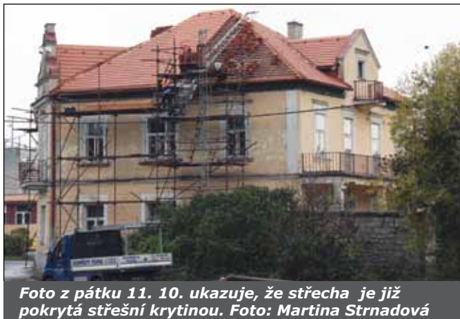
Také oprava střechy domu na Ostrůvku probíhá během letošního podzimu. Foto: Iva Horká
