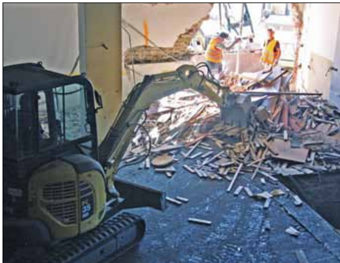
Otvorem ve zdi se pracovníci dostávali do velkého sálu od řeky Balinky. Foto: Martina Strnadová
