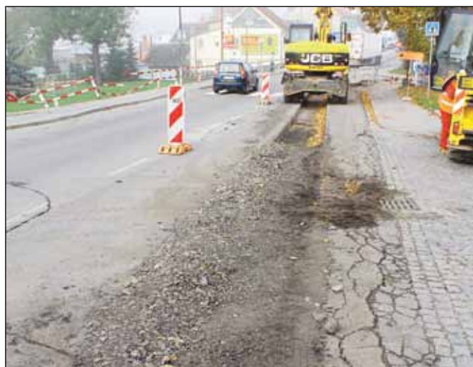
Kvůli probíhající opravě kanalizací na Karlově je zde doprava řízena semafor. Foto: Iva Horká
