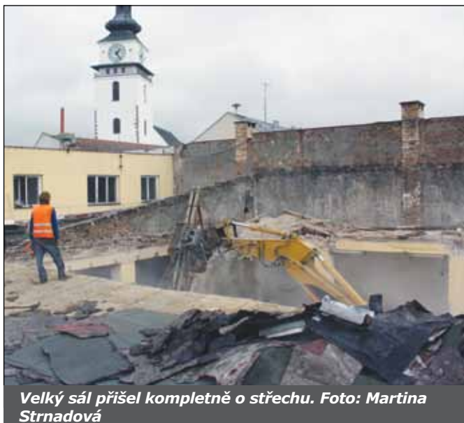
Bagr rozebíral konstrukci krovu nad sálem. Foto: Martina Strnadová
