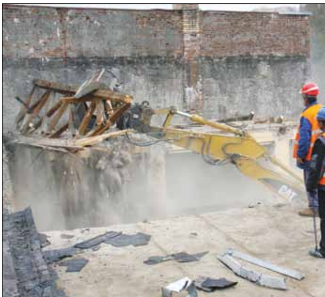
Bagr rozebíral konstrukci krovu nad sálem. Foto: Martina Strnadová
