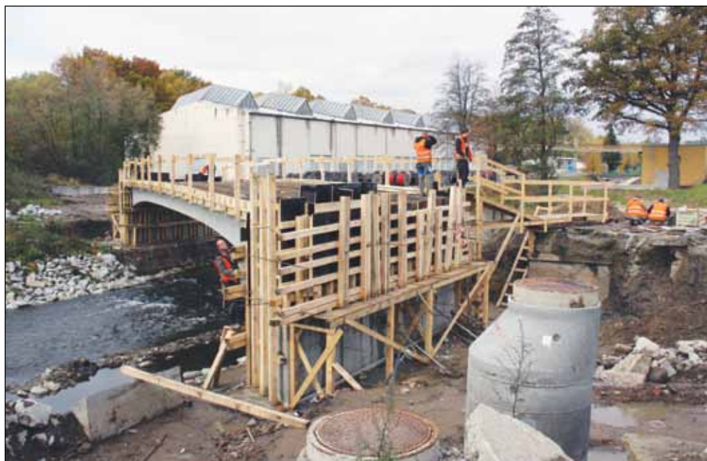
Snímek zachycuje fázi výstavby nového mostu v areálu nkt cables z minulého týdne. Práce pokračují, ale do zimy nejspíš hotovy nebudou. Foto: Martina Strnadová
