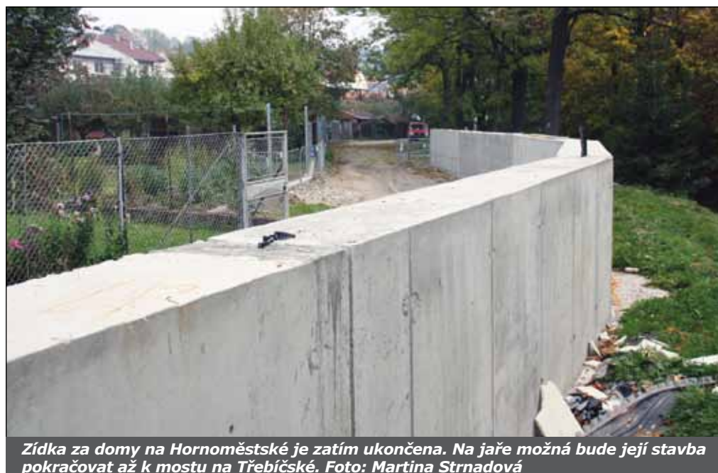
Stavba protipovodňových zídek v současné době probíhá za mostem na Třebíčské. Foto: Martina Strnadová
