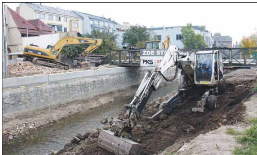
Za Jupiter clubem se nyní potkaly dvě velké stavby – protipovodňová opatření a rekonstrukce velkého sálu. Foto: Martina Strnadová
