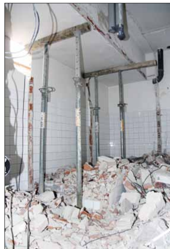
Místnosti, které se bourat nebudou, mají vyztužený strop. Foto: Martina Strnadová
