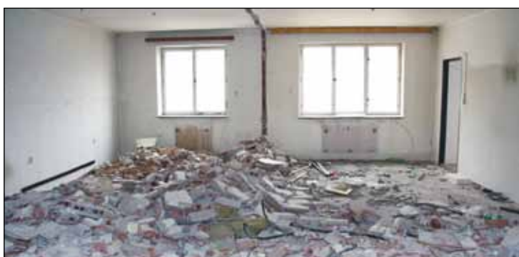
Pohled na vchod na galerii od restaurace (nahore) a do bývalého bytu domovníka. 2x foto: Martina Strnadová
