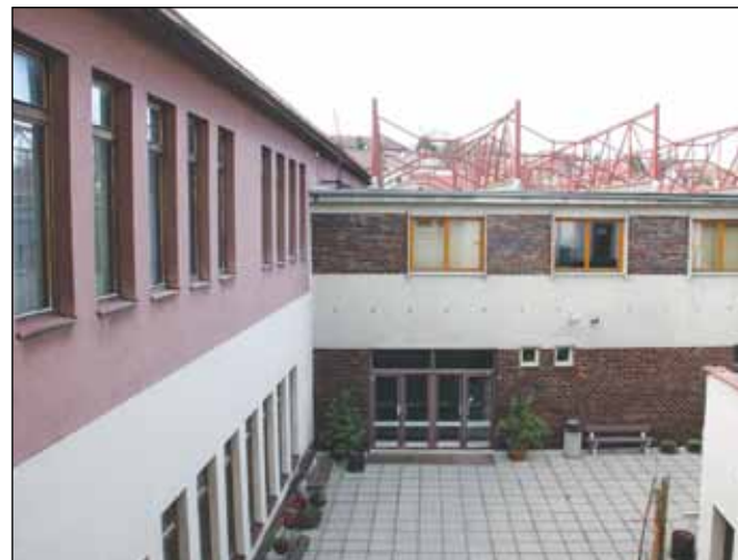
Vlevo nahoře výstavní síň, dole loutková scéna, v pozadí vstup do kina a nahoře koncertní sál, to vše je součástí nové budovy JC. Foto: Martina Strnadová
