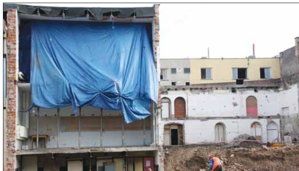
Demolice v Jupiter klubu se zčásti dotkla i vedlejší budovy č. 18, kde je odbourává část výstavního sálu, pod ním maskérny a dole sklepních prostor. Foto: M. Strnadová
