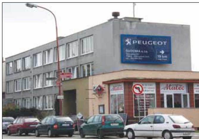
Obytný dům s prodejnou masny na Sokolovské ulici. Foto: Martina Strnadová
