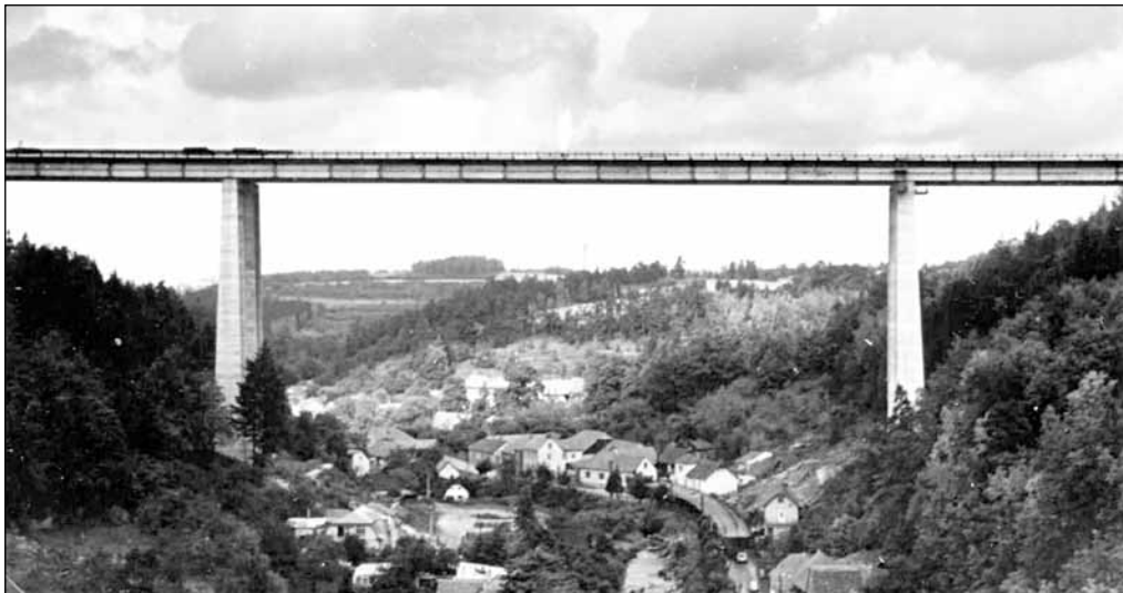
Již 35 let se nad městem tyčí dálniční most Vysočina. Na dálnici D 1 je nejvyšším a druhým nejdelším mostem. Provoz na něm byl slavnostně zahájen 28. listopadu 1978.
