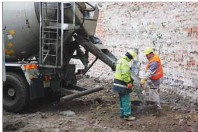
V prostou vybouraného velkého sálu JC začala stavební firma vrtat a betonovat piloty. Foto: Martina Strnadová
