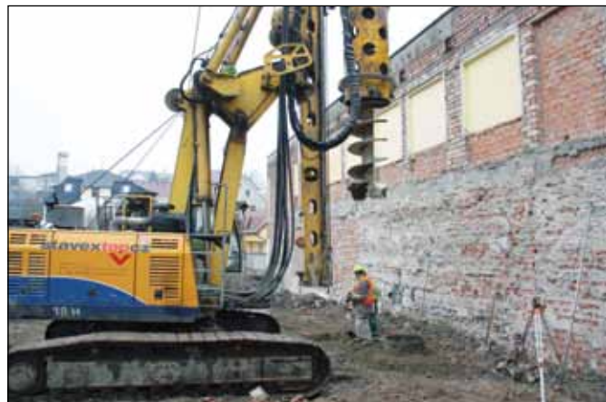
V prostou vybouraného velkého sálu JC začala stavební firma vrtat a betonovat piloty. Foto: Martina Strnadová
