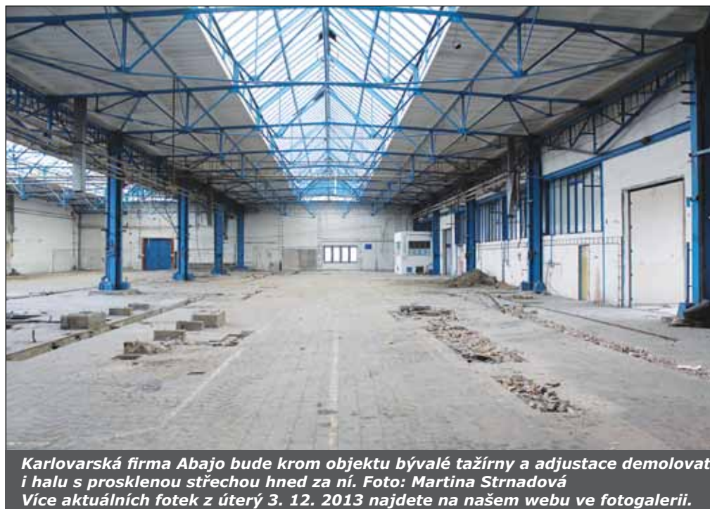
Administrativní budova kablovky s vrátnicí je již zcela pryč. Objekt kuchyně úplně vpravo se bourat nebude, zato budovu, z jejíž střechy je snímek vyfocen, demolice teprve čeká. Foto: Martina Strnadová
