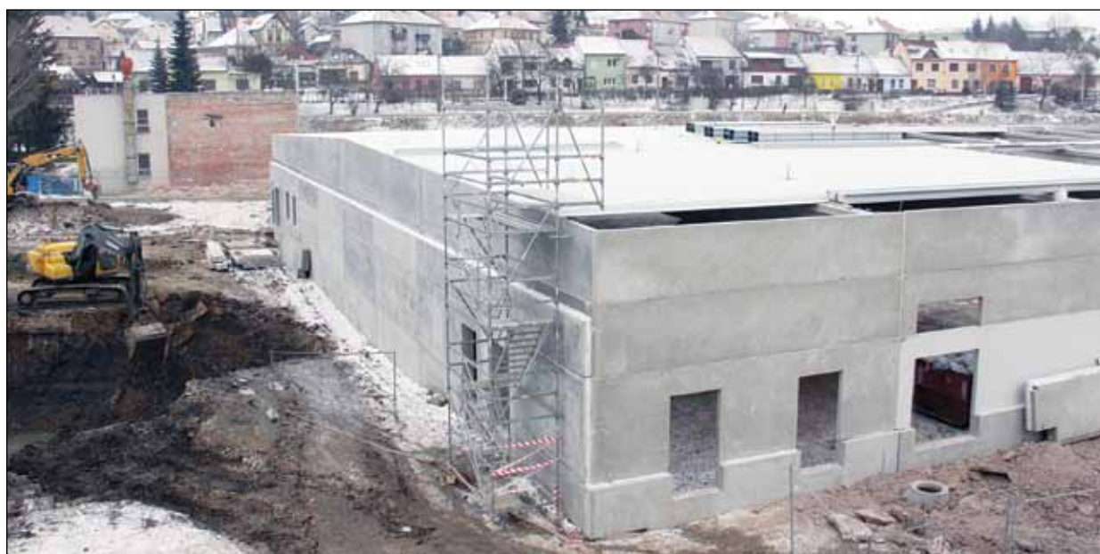
Výstavba nového obchodního domu v areálu velkomeziříčské kablovky pokračuje rychle. Hotovo by mělo být v červnu. Foto: Martina Strnadová
