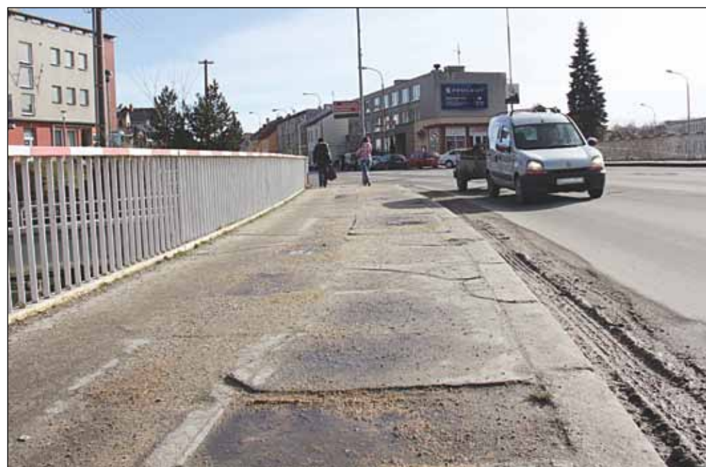
Rekonstrukce krajské komunikace II/602 bude letos pokračovat od pošty na východ. Most na snímku ale nyní opravovat nebudou. Foto: Martina Strnadová
