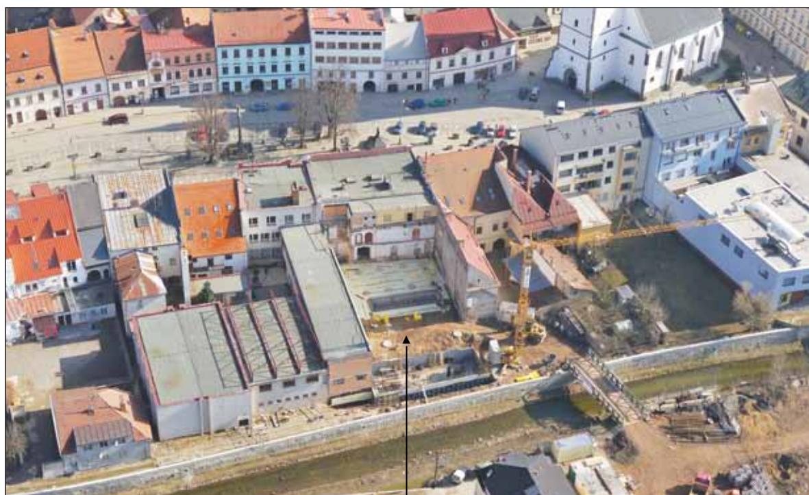
Výstavba nového víceúčelového sálu Jupiter klubu (dům uprostřed, jak ukazuje šipka) ve Velkém Meziříčí na leteckém snímku. Foto: Jiří Trojan
