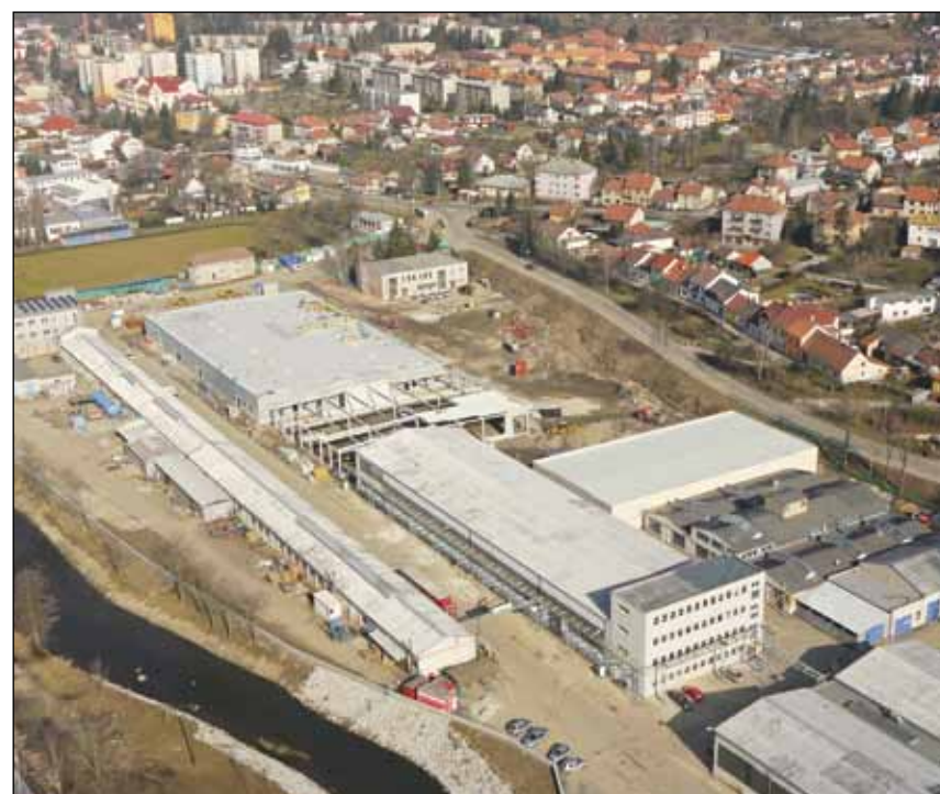
Letecký snímek zachycuje stav výstavby nového obchodního domu v areálu bývalé Kablovky ve Velkém Meziříčí. Foto: Jiří Trojan
