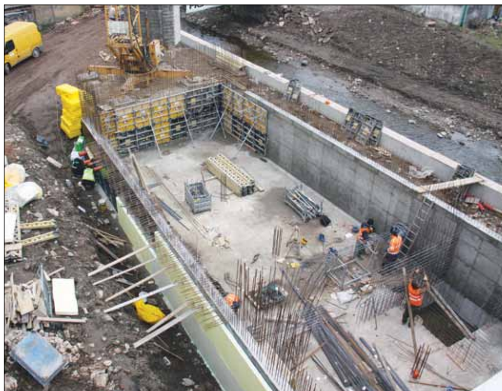
Téměř dokončená betonová „vana“ pod budoucím jevištěm, kde bude technické zázemí. Foto: Martina Strnadová
