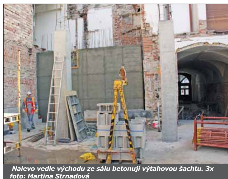
Začala stavba stěny ze ztraceného bednění vedle farní zdi.
