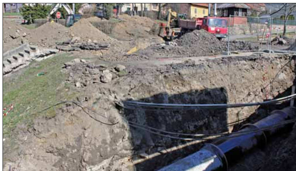
Rušno je i na stavbě okružní křižovatky k obchodnímu centru, což ukazují snímky vlevo i vpravo. Zatím probíhá hlavně přeložka sítí. 2x foto: Martina Strnadová
