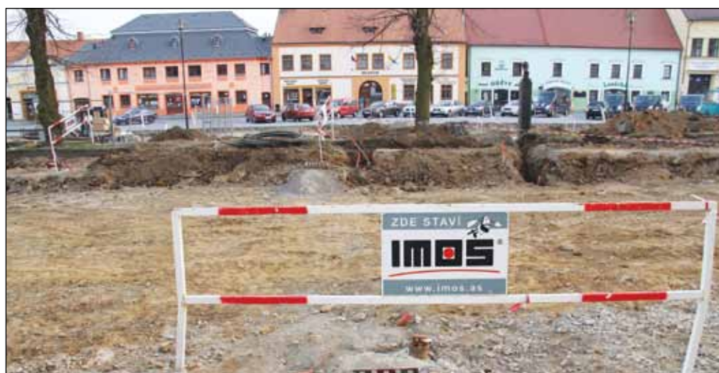
Parkování aut je na bítešském náměstí velmi omezeno. Jak ukazuje snímek, polovina prostoru je rozkopaná, na druhé stojí vozidla. Foto: Iva Horká
