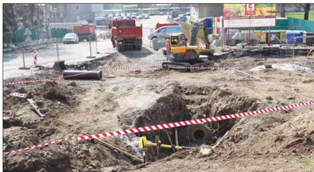
Pohled na výstavbu okružní křižovatky z ulice Karlov. Nejen odtud budou auta přijíždět k novému supermarketu. Foto: Martina Strnadová
