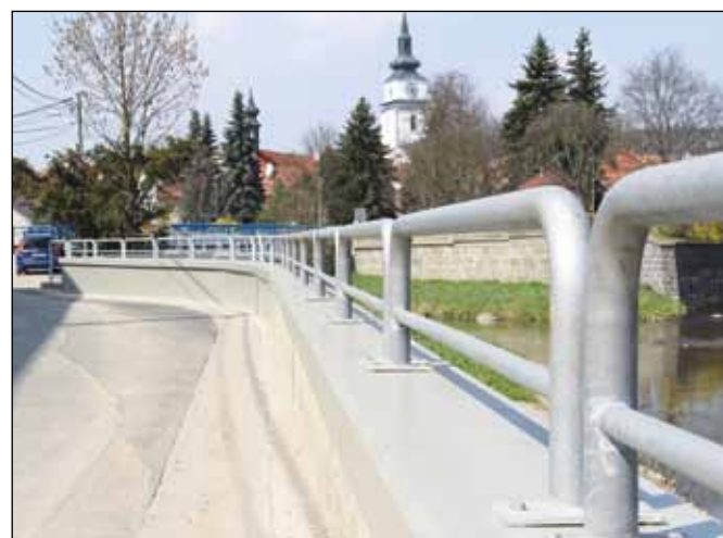
Zídka opatřená zábradlím je již natřená antigrafitovou vrstvou. Foto: Martina Strnadová
