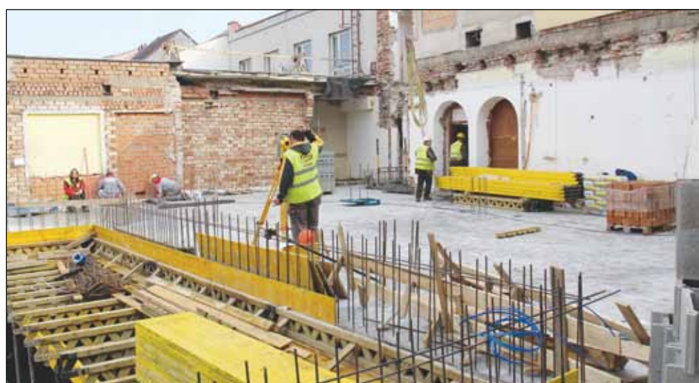
Budoucí galerie jsou již vylity betonem. Práce začaly probíhat koncem minulého týdne. Foto: Martina Strnadová
