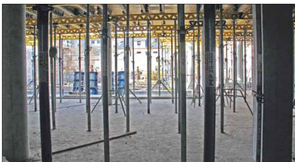
Příprava šalování pro betonování budoucích galerií nad hledištěm a hlavním sálem. Foto: Martina Strnadová
