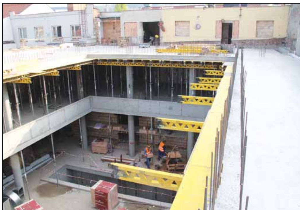
Jsou již hotové galerie s vybetonovaným stropem (foto vpravo). Vlevo dole je vidět propojení staré a nové budovy Jupiter klubu. 4x foto: Martina Strnadová
