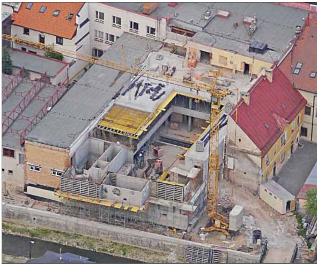
Na leteckém snímku Jiřího Trojana z minulého týdne je zřetelně vidět, jak pokročily práce na výstavbě nového víceúčelového sálu Jupiter klubu ve Velkém Meziříčí.
