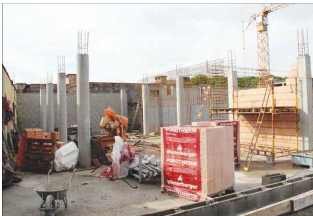
Vpopředí snímku je vidět terasa nové kavárny, odkud bude výhled na západní část města. Foto: Martina Strnadová
