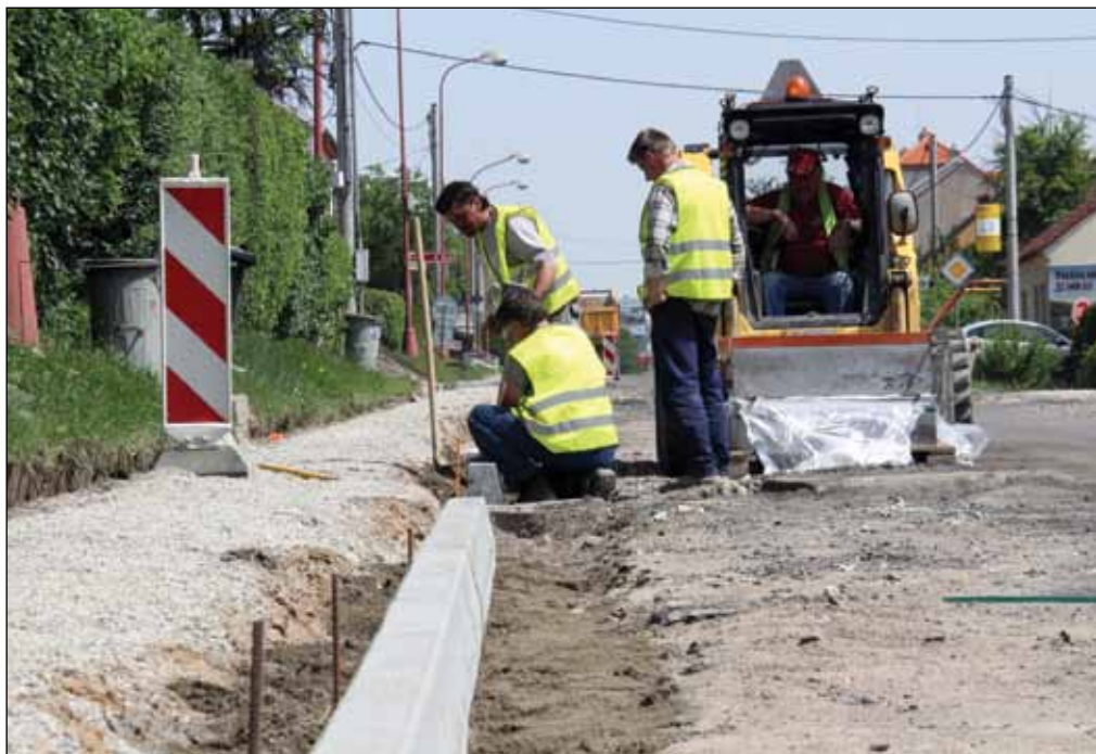
Nyní probíhá betonování obrub. V jiných místech se pracuje na odstraňování starých krajinic. V ulici je klid, místní už si na objížďku zvykli. Foto: Martina Strnadová
