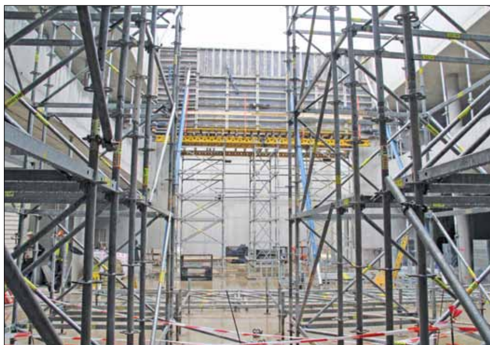
V minulém týdnu stavebníci připravovali podpěry pro betonování střechy nad víceúčelovým sálem Jupiter clubu. Více foto str. 4 a na webu. Foto: Martina Strnadová
