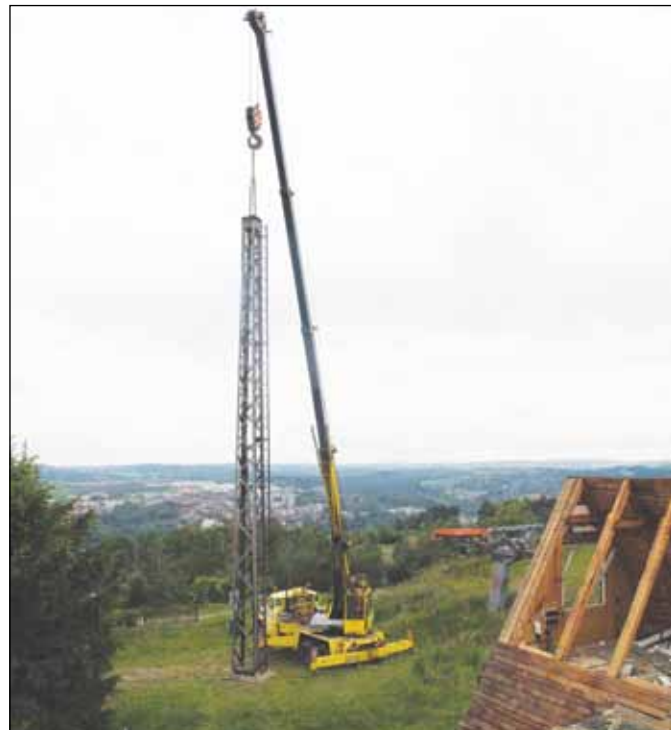
Nejde o stavbu rozhledny, ale o přípravu staveniště demontáže anténního sloupu radioamatérů a odstranění původní budovy vleku. Text a foto: -pz-
