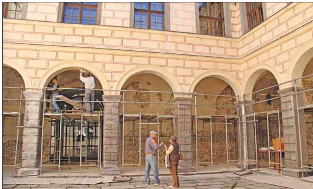
Majitelé budovy bývalého luteránského gymnázia opravují podloubí atria. Foto: Iva Horká
