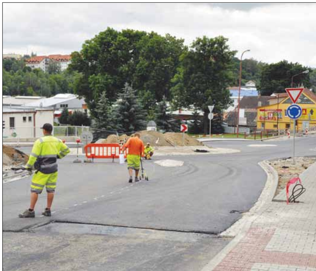
Práce na dokončování nové křižovatky probíhaly o uplynulém víkendu. Provoz tam byl omezen. Více fotografií si můžete prohlédnout na našich webových stránkách www.velkomeziricko.cz . Foto: Martina Strnadová
