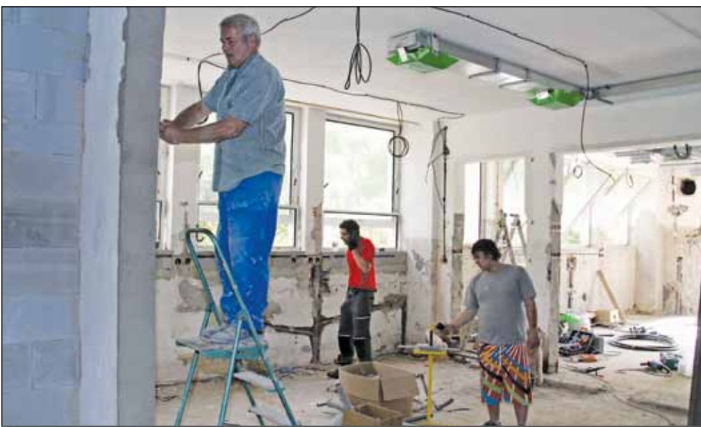
Na Světlé probíhá kompletní přestavba cvičné kuchyně. Foto: Martina Strnadová
