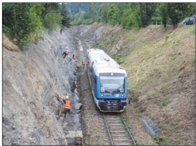
Zajišťující práce na železnici kolem hřbitova na Karlově ve Velkém Meziříčí. Foto: Martina Strnadová
