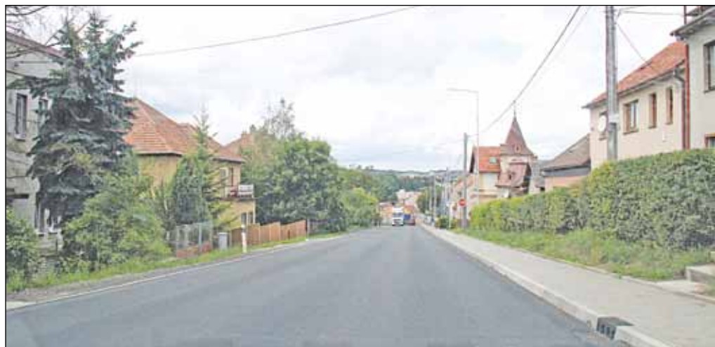
Řidiči jedoucí přes Velké Meziříčí mohou opět projíždět po silnici 602 na Karlově. Po opravě je od minulého týdne průjezdná. Foto: Iva Horká
