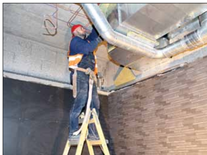
Probíhá instalace vzduchotechniky. Foto: Martina Strnadová
