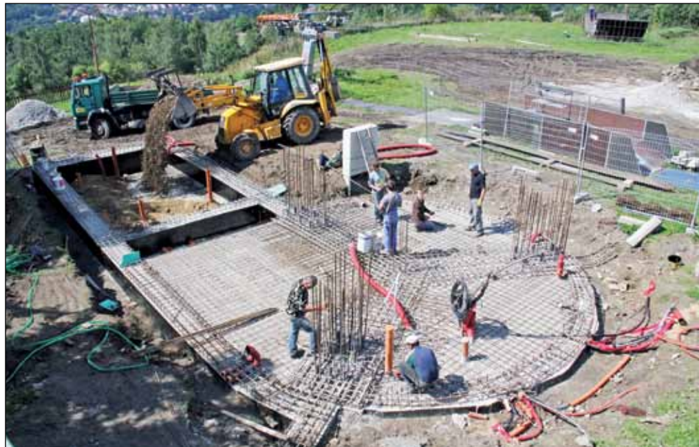
Snímek ukazuje základny budoucí rozhledny na Fajtově kopci. Akce je spolufinancována Evropskou unií - viz foto vpravo. 2x foto: Martina Strnadová
