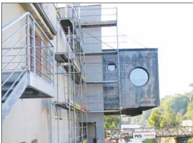
Zezadu je objekt zateplen, maskérna je obložena ocelovými pláty. Foto: Martina Strnadová
