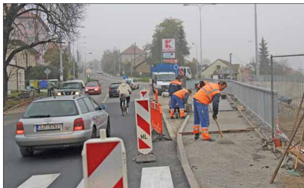
Snímek zachycuje opravený úsek pod kruhovým objezdem u Tržiště. Foto: Martina Strnadová
