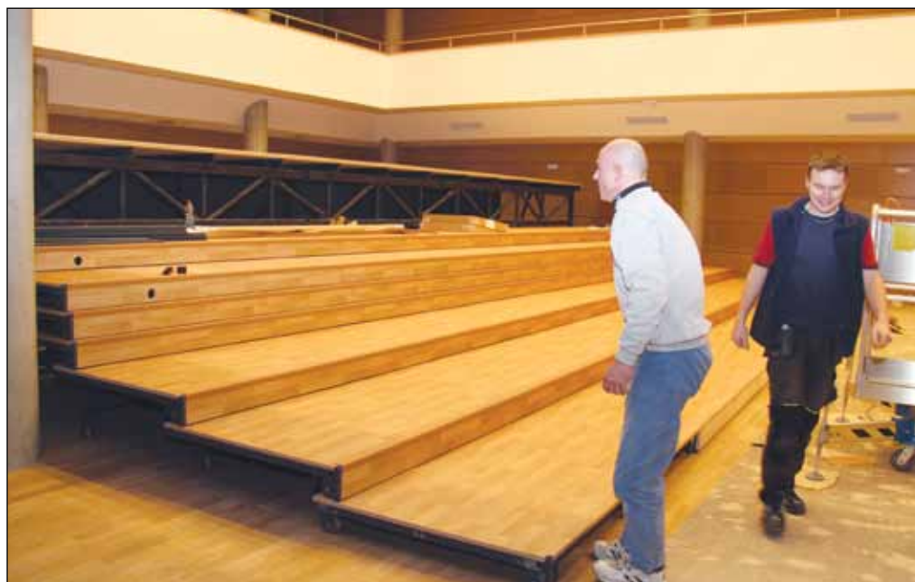
Montáž elevačního hlediště v sále Jupiter klubu zahájili pracovníci minulý týden. Foto: Martina Strnadová
