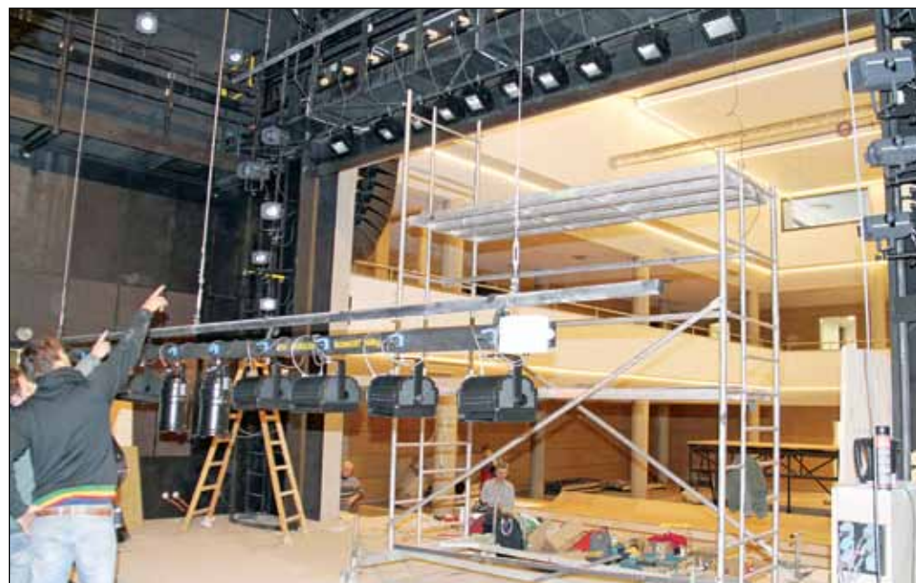
Pokračuje také instalace osvětlení a další jevištní techniky. Foto: Martina Strnadová
