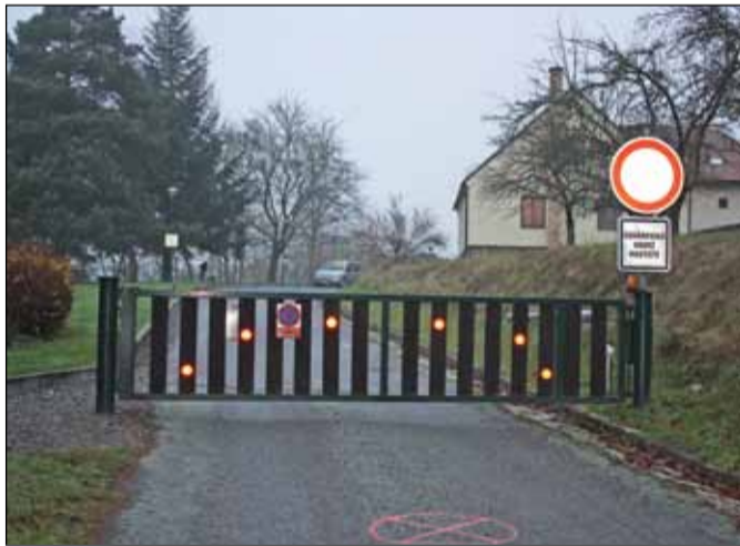
Vjezd na hráz je autům již nyní zamezen závorou od Vídně. Snímek je z 30. 11. 2014. Foto: Iva Horká
