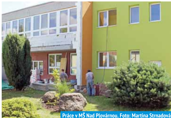
Práce v MŠ Nad Plovárnou. Foto: Martina Strnadová
