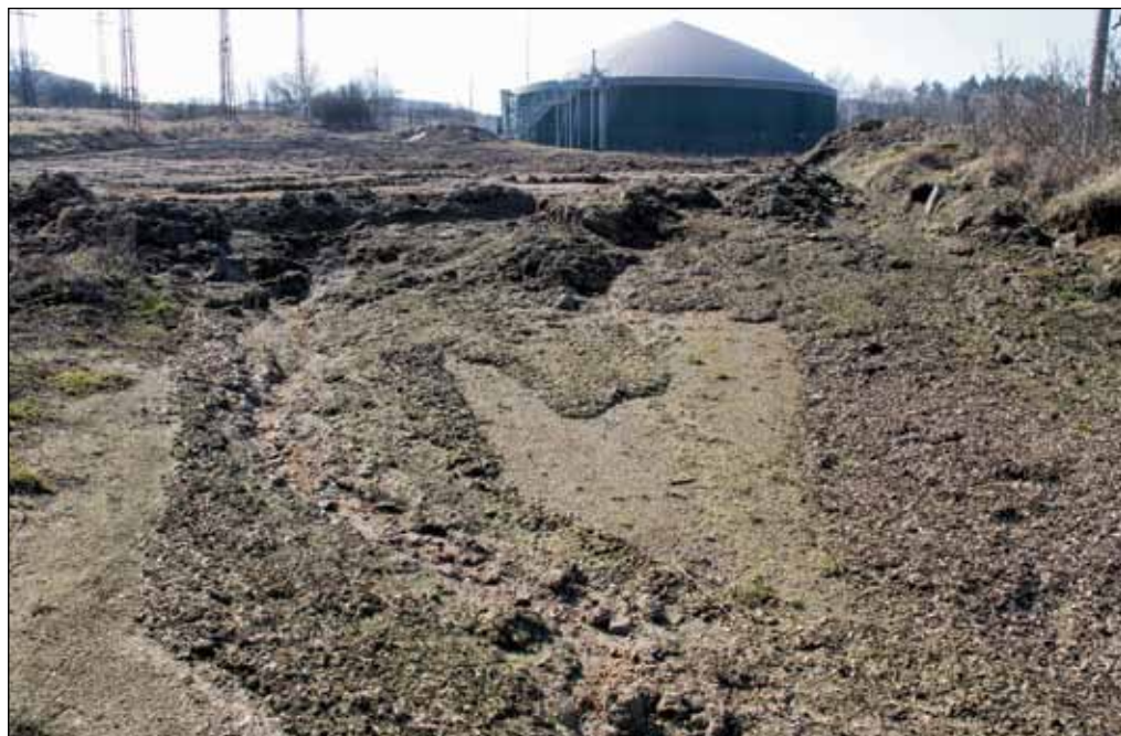
Z nevhodně uskladněné kukuřičné siláže unikaly závadné látky z prostoru bioplynky, jak zachycuje tento snímek. Foto: Martina Strnadová
